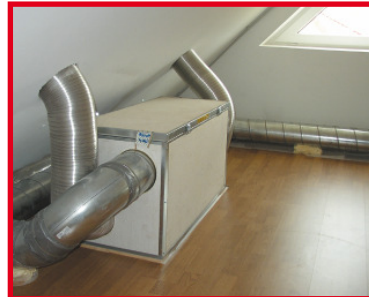
Optional Kontrollierte Be- und Entlüftungsanlage
